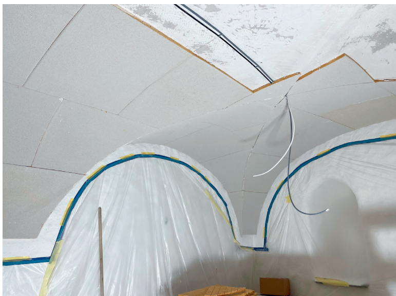
Die Platten werden an der Decke verklebt.
