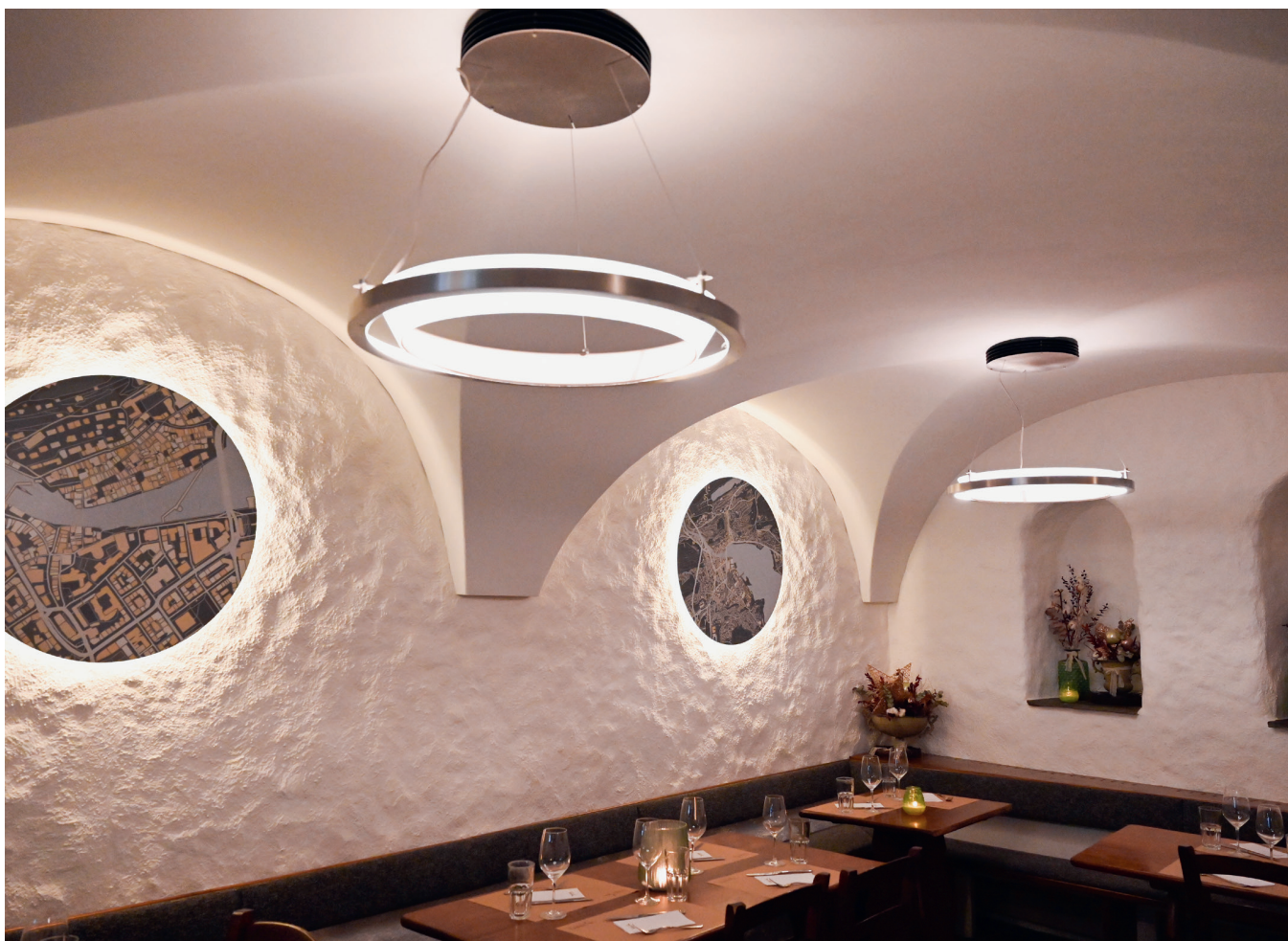
Die Kreuzgewölbedecke im Wirtshaus Taube ist akustisch optimiert. Bild: Cornelia Sigrist
